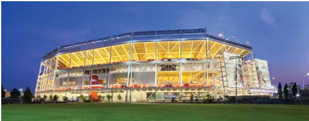
Vanjski pogled na čeličnu konstrukciju i otvoreno pročelje stadiona San Francisco Bay Area
