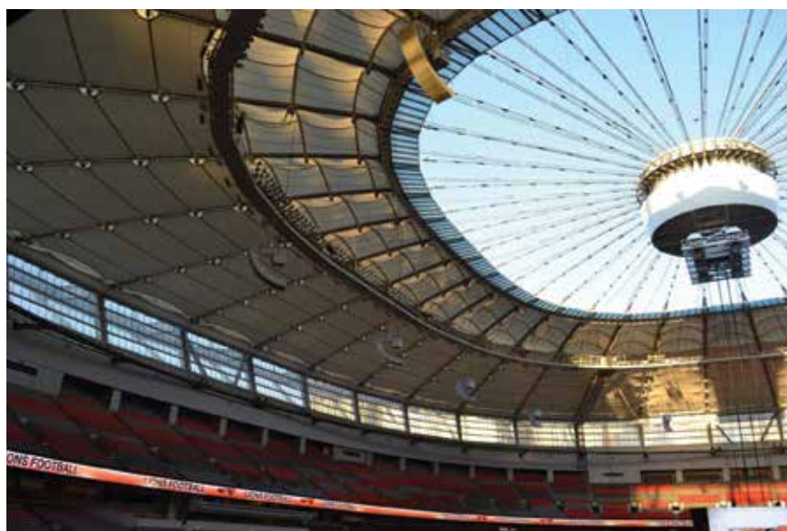
Pogled iznutra na krovnu membranu
