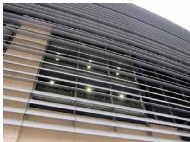
Detalj fasade stadiona – aluminijske žaluzine
