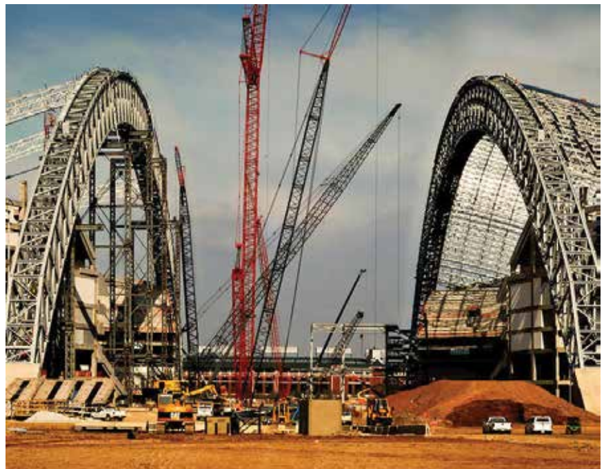
Detalj s gradilišta
