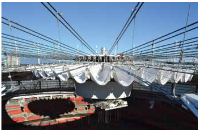
Središnji ovjesni element krovne konstrukcije
