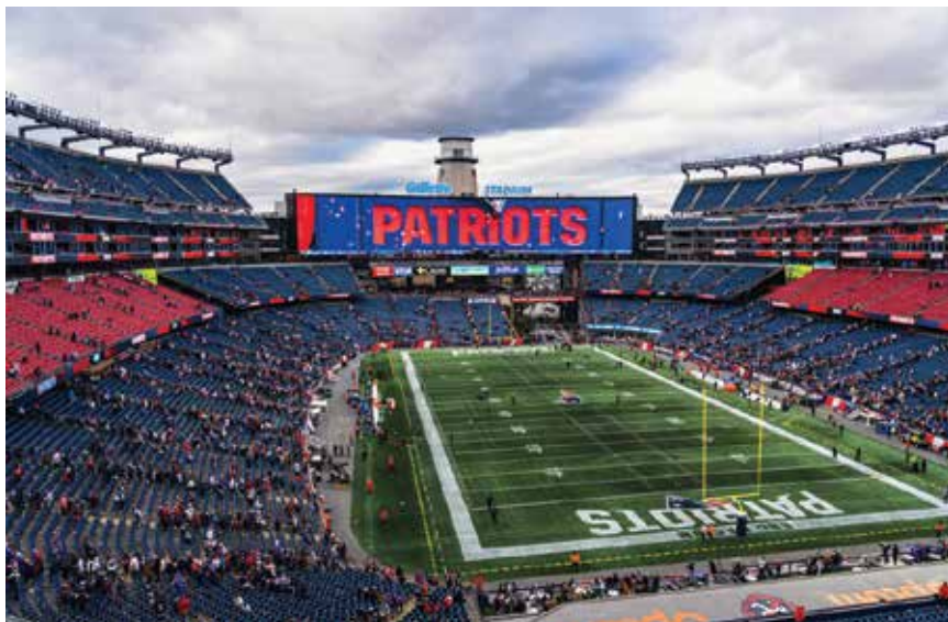
Unutrašnjost armiranobetonske konstrukcije oblika zdjele stadiona
