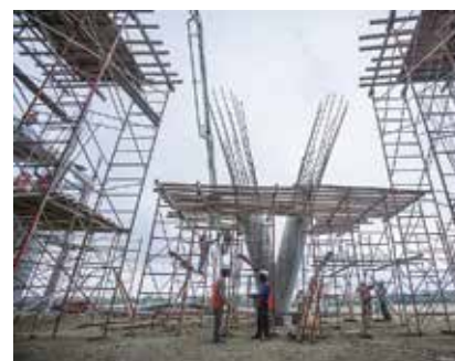
Izvedba stupova na gradilištu
