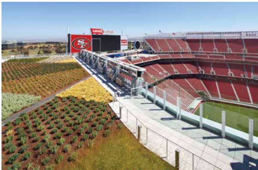
Zeleni krov na zapadnom dijelu gornjeg prstena zdjele stadiona u San Franciscu
