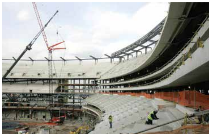
Pogled na gradilište tribina
